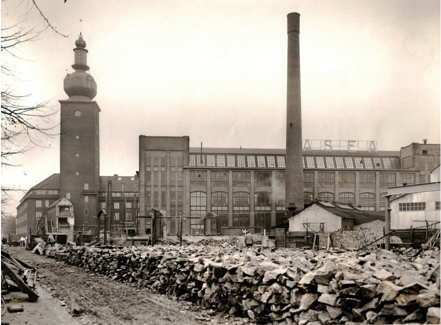
Mimer byggs till längs Södra Ringvägen 1930. Foto: ABB-arkivet, Västmanlands läns museum.
